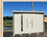
上坪地区防災倉庫
